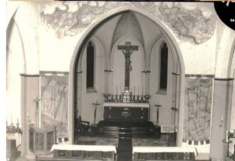
1958 wurde die Pfarrkirche renoviert und der Erzengel Michael über den Chorbogen sowie die beiden Wandteppiche vor dem Chorraum geschaffen.
