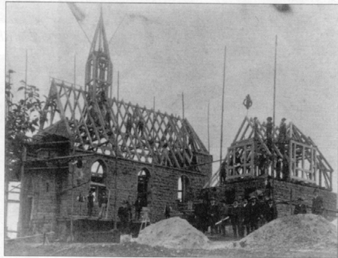
Richtfest am 15. September 1909
