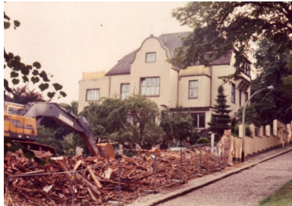
1997 der Abriss des kleinen Hauses, mit all seinen Geschichten, brachte einige Tränen
