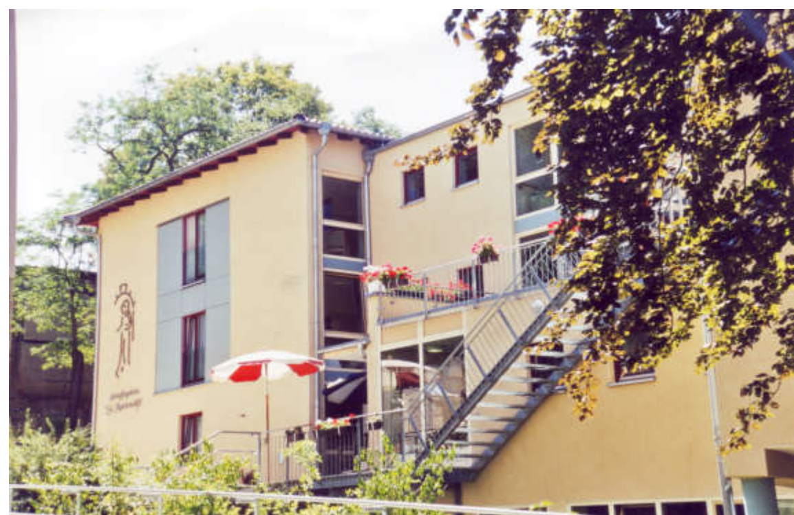
Der Neubau des St. Marienstiftes von der Ostseite
